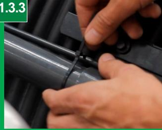
Utilizando as abraçadeiras fitas, fixe bem os tubos de nylon, neste serão utilizadas abraçadeiras fita, mas existe também as abraçadeiras redondas com rebites, para casos onde não existam lugares para amarração.
