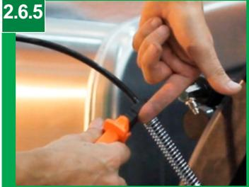
Encaixe a calota no eixo e corte o tubo na outra extremidade deixando aproximadamente 2 cm para fazer a ligação.
